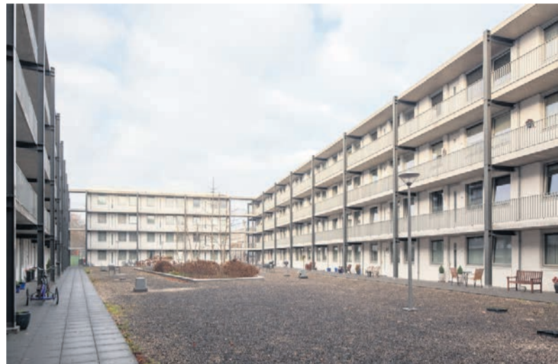
Binnen- en buitenschilderwerk aan 104 galerijwoningen in Nuenen met biobased verf van Copperant
